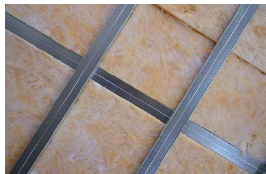
Dämmung über den CD- Profilen
