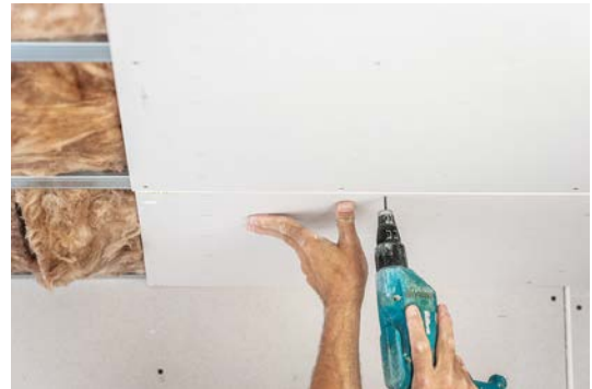
gedämmte abgehängte Decke - Befestigung der Gipskartonplatten
