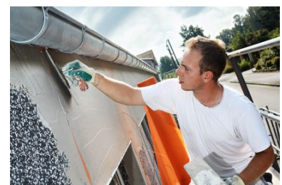
3 Schicht Armierungsmörtel
