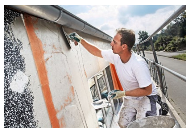
2 Armierungsgewebe einbetten
