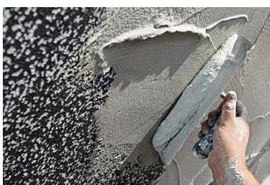
1 Schicht Armierungsmörtel
