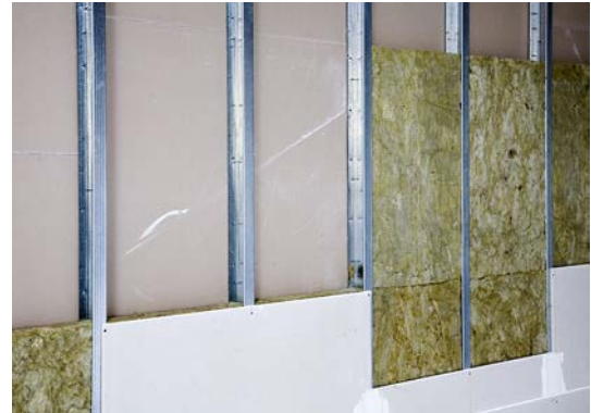
Aufbau einer Trennwand mit Metallprofilen
