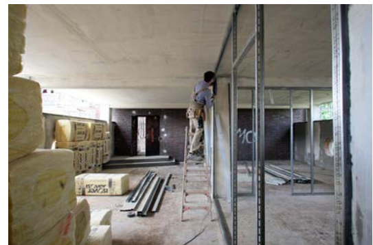
Montage Trennwand mit Metallprofilen
