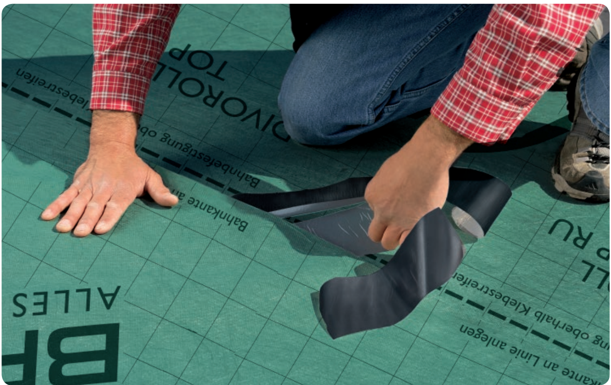
Mit den Divoroll Unterdeck- und Unterspannbahnen und dem perfekt darauf abgestimmten Zubehör wird die Behelfsdeckung zum Kinderspiel. Besonders zu empfehlen: Unterdeck- und Unterspannbahnen mit Klebestreifen für eine nahtgesicherte und winddichte Unterdeckung oder Unterspannung.
