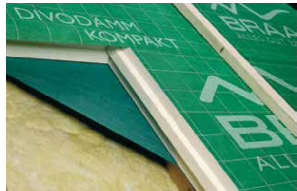
Beispiel: geschlossene Deckunterlage mit DivoDämm.
