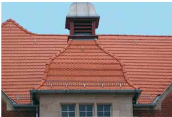
Dachkrümmung mit Längskonvex-/Längskonkavbibern, in Kronendeckung eingedeckt.
