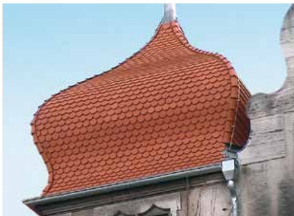
Mit Graten verbundene Zwiebeldachflächen, in Doppeldeckung eingedeckt.
