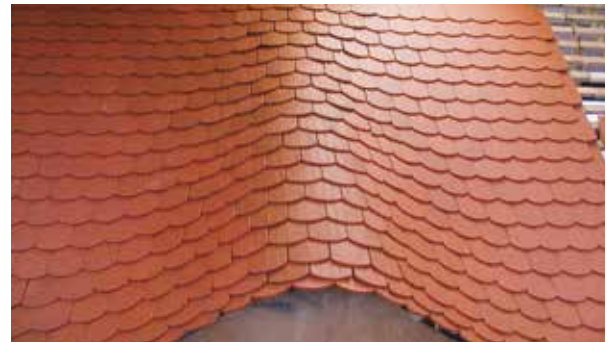
Testeindeckung mit Opal Sonderbiberschwanzziegeln auf Fledermausgaube im Verhältnis Breite zu Höhe von nur 5 : 1.
