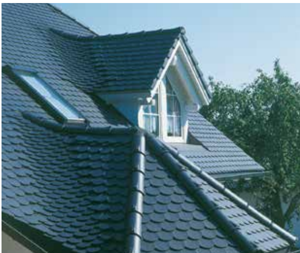
Harmonischer Kehlübergang bei Erker- und Gaubendächern.
