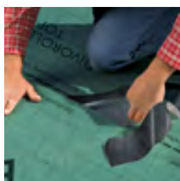
1. Folie abziehen und Bahnen verkleben
